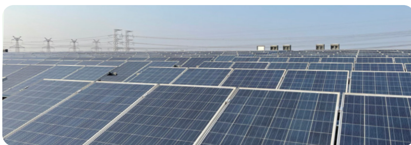
铺设光伏板厂房
